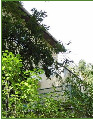
Dózsa György utca 45. 1920-as évek bauhaus villa épület, részben átépült
