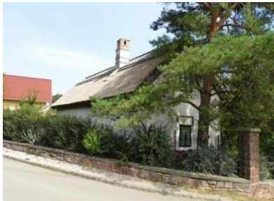
Dózsa György utca 5. népi építészeti örökség
